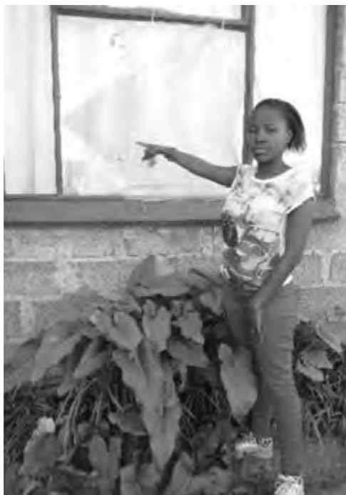
Kunene mostra il vetro di casa sua, rotto a seguito delle esplosioni nella vicina miniera.
