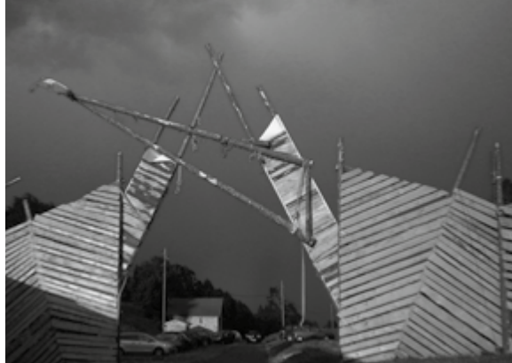
Ecco l'entrata del campo cantonale, ancora in costruzione.
